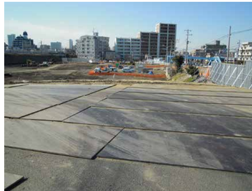
盛土の整地が進む18班地区(1月19日土手上より撮影)
