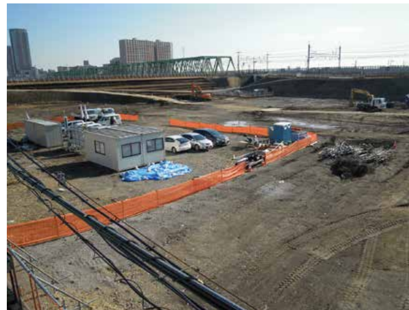
歩道橋からみた18班地区の工事現場(1月19日撮影)
