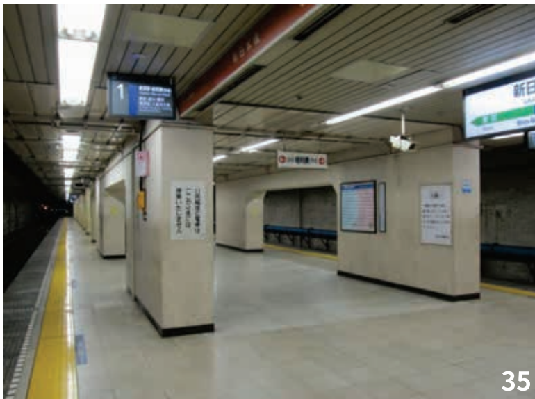
35：銀座線交差部分は支柱が鋼管柱ではなくコンクリート壁
