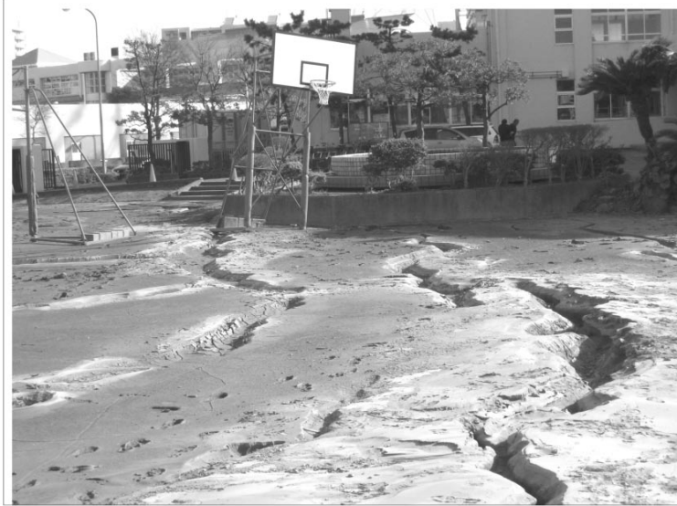
校庭に噴砂や液状化で亀裂が走った清新第一中学校
